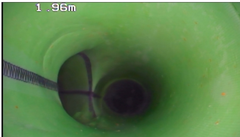
Sicht auf Hauptrohr in Fließrichtung
